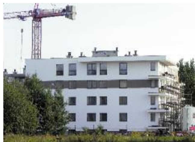
Prace na placu budowy postępują bardzo szybko.
